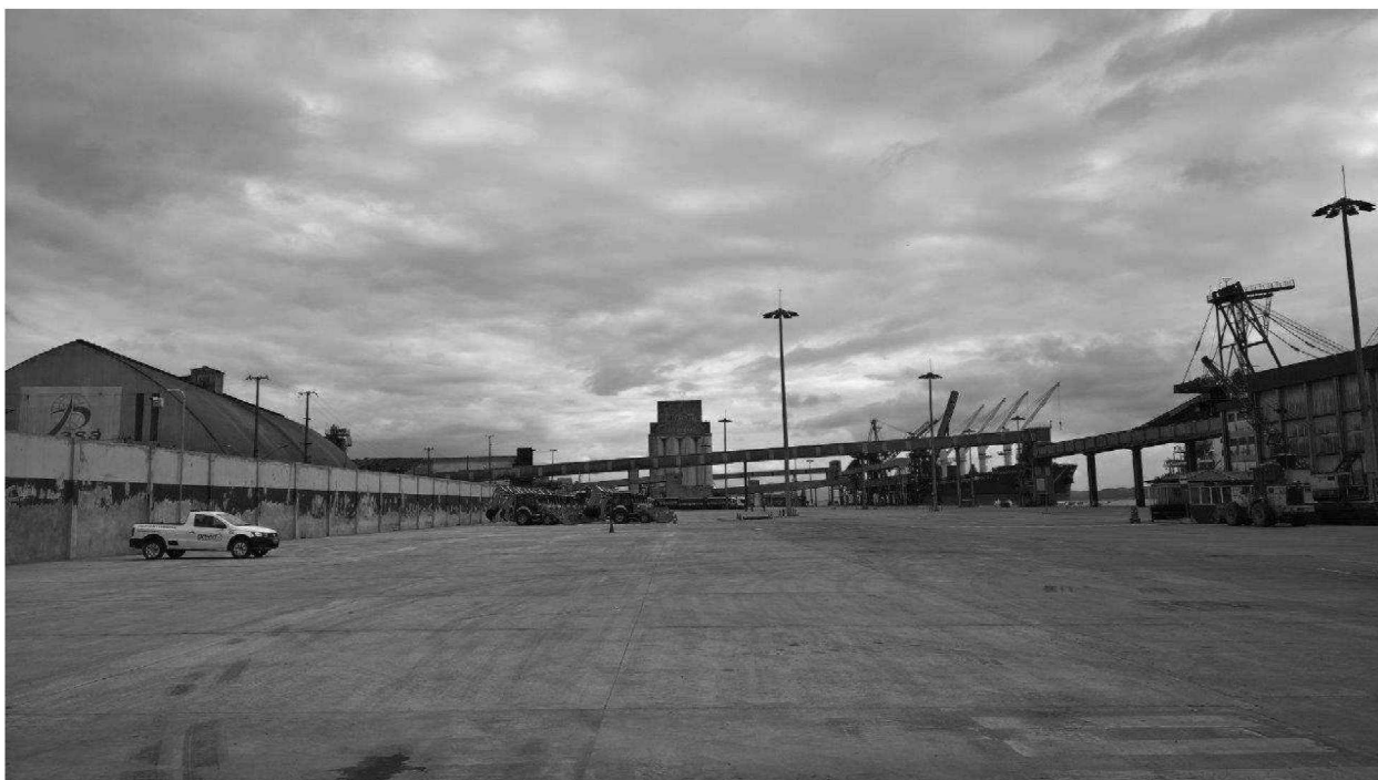
Figura 3.1.2.1-1: Área onde encontravam-se os armazéns.
